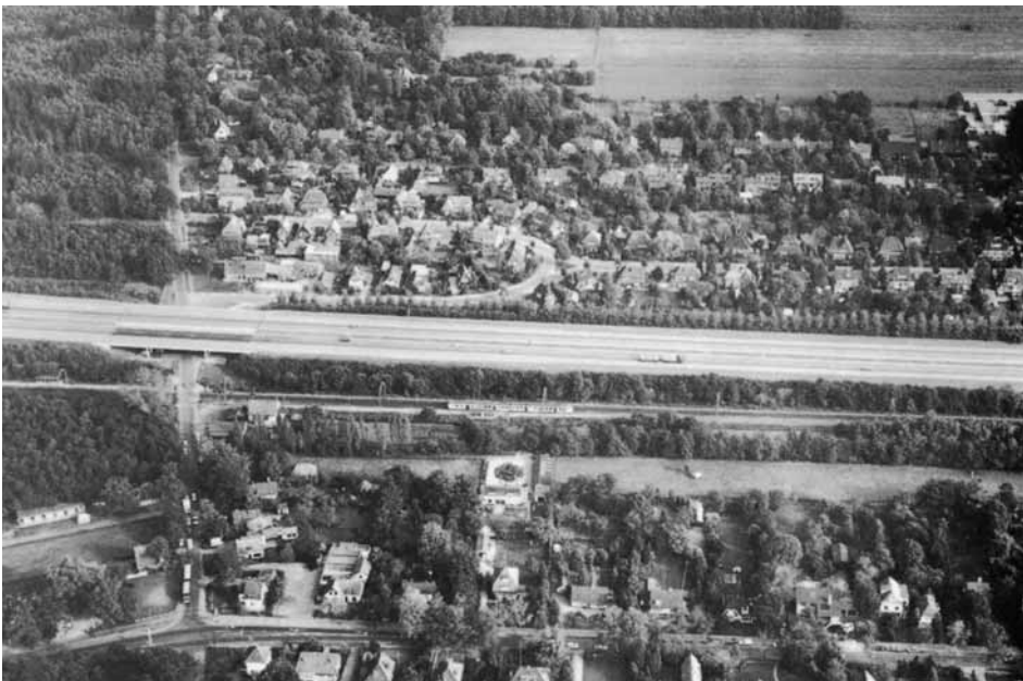
Hollandsche Rading. Cumulatie geluid. Duidelijk zijn de drie bronnen: de rijksweg, het spoor en de provinciale weg te onderscheiden.
