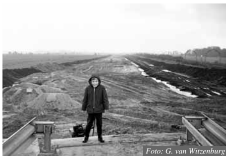
Rijksweg in aanleg, richting Groenekan
